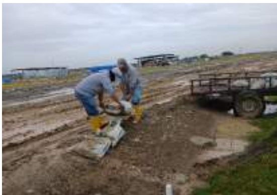
Actividad: Colocación de barreras de sacos en el perímetro del hoyo 15
