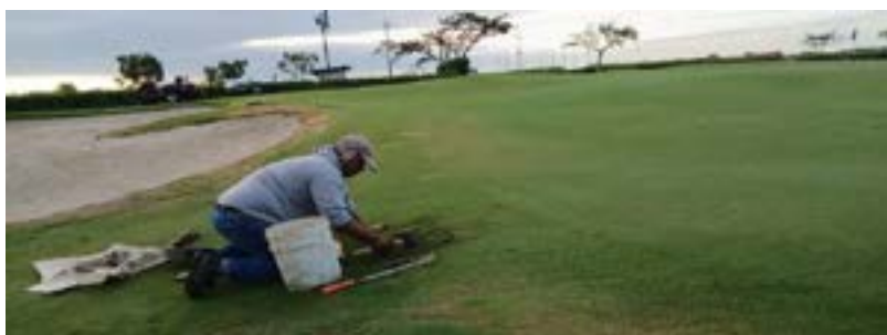
Actividad: Nivelación de aspersores en antegreens Duración: 20, 21, 22 y 23 de julio
