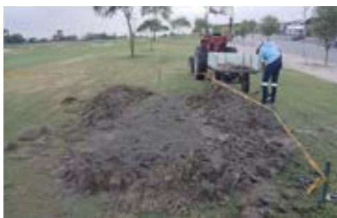
Actividad: Arreglo daño hidráulico en rough hoyo 1 Duración: 13, 14 y 15 de julio
