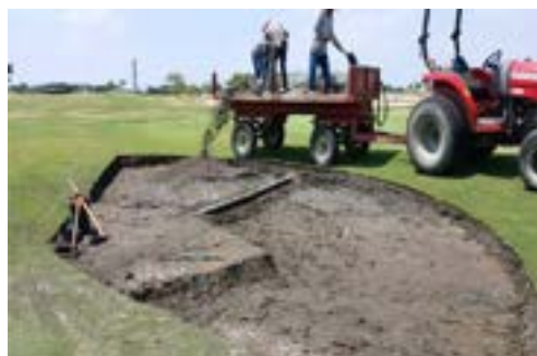
Actividad: Arreglo sumidero (drenaje) antegreen hoyo 11 Duración: 13, 14, 15, 16 y 17 de julio
