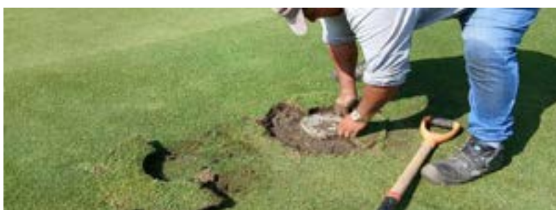
Actividad: Nivelación de aspersores en antegreens Duración: 14, 15, 16 y 17 de julio
