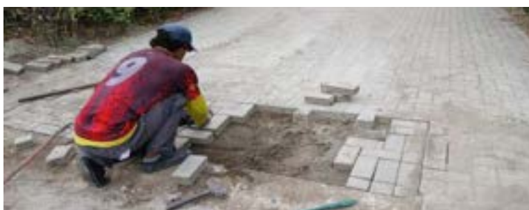
Actividad: Nivelación de adoquines para tránsito de maquinaria Duración: 28 y 29 de julio
