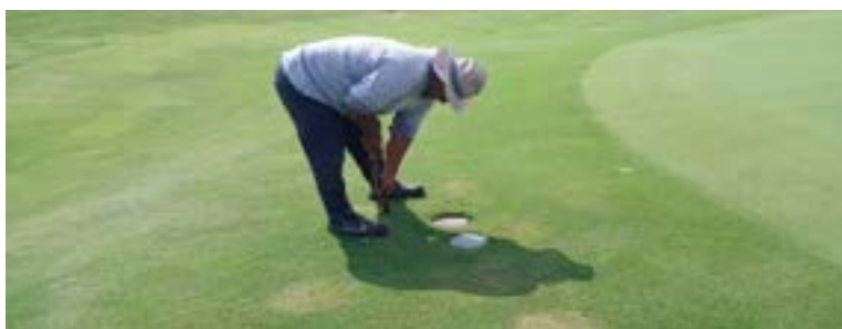
Actividad: Nivelación de aspersores en antegreens Duración: 30 y 31 de julio
