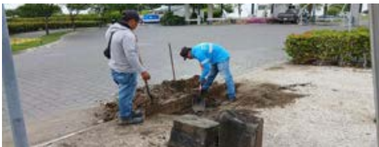
Actividad: Arreglo daño hidráulico rough hoyo 1 Duración: 27 de julio
