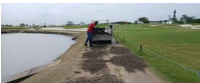
Actividad: Nivelación con arena en carpath hoyo 6 Duración: 14 de julio
