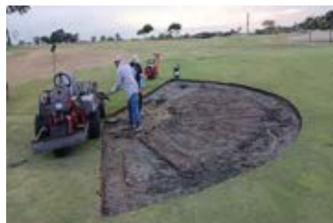
Actividad: Arreglo sumidero (drenaje) antegreen hoyo 11 Duración: 13, 14, 15, 16 y 17 de julio
