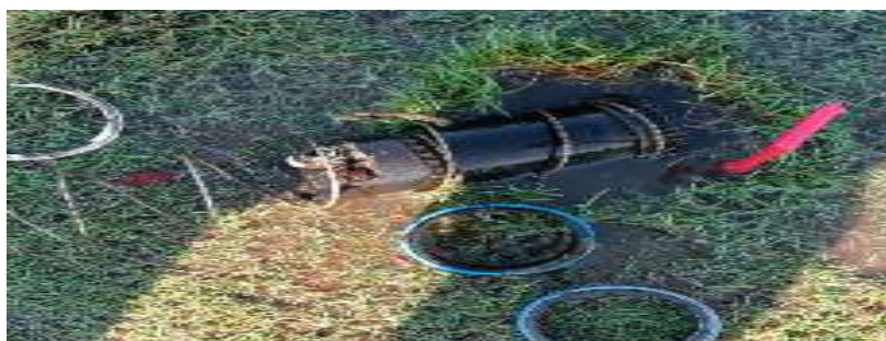
Actividad: Cambio de retenedor en hoyo 10 Duración: 20 de julio
