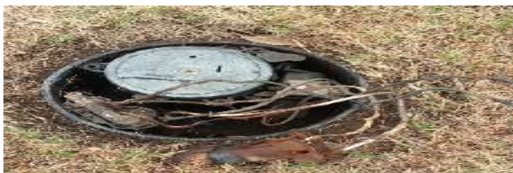
Actividad: Reemplazo de cable sulfatado en hoyo 4 Duración: 16 de julio
