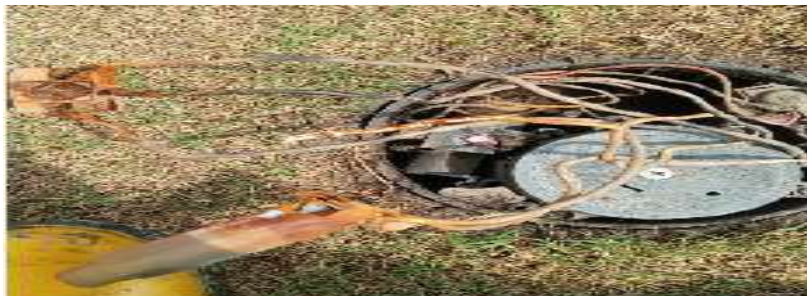
Actividad: Cable sulfatado en hoyo 10 Duración: 20 de julio
