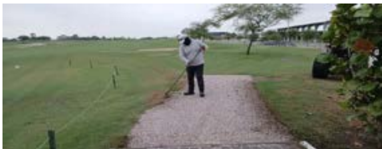
Actividad: Alineamiento de piedra chispa en salidas de car path Duración: 30 y 31 de julio
