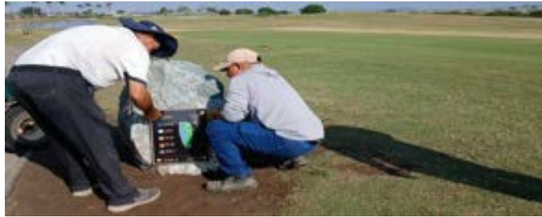
Actividad: Instalación de tótems (placas) en los hoyos (tees) Duración: 09 y 10 de julio
