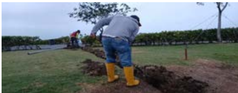
Actividad: Instalación de tubería para dragado manual Duración: 30 de julio
