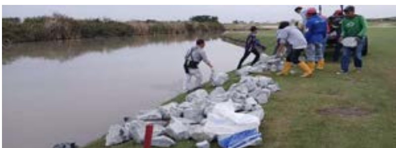
Actividad: Enrocado hoyo 6 Duración: 23 de julio
