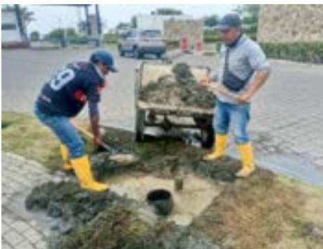
Actividad: Arreglo hidráulico en garita secundaria Duración: 24 y 25 de junio
