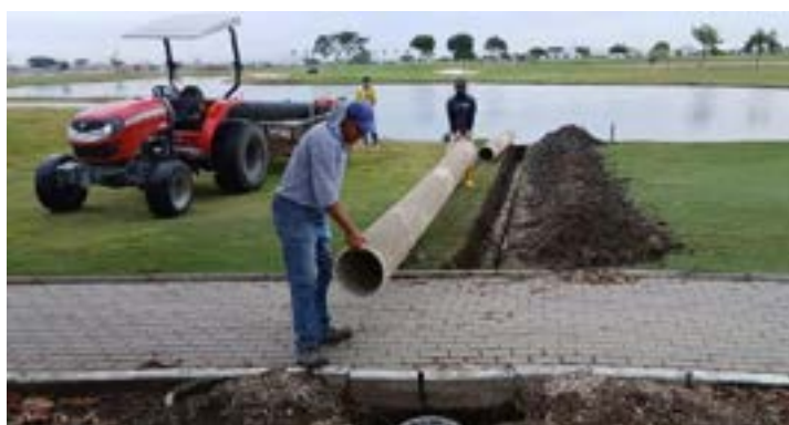
Actividad: Cambio de tubería de drenaje de 6 a 12 pulgadas en hoyo 15 Duración: 04 y 05 de junio
