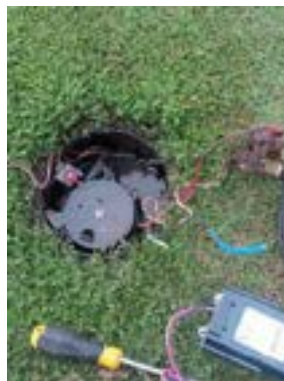
Actividad: Arreglo de cable sulfatado en hoyo 11, 13, 16 Duración: 08 de junio
