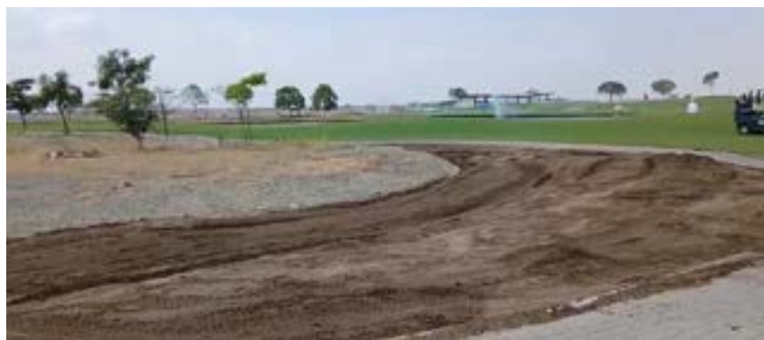
Actividad: Nivelación en perímetro del hoyo 17 Duración: 02, 03 de junio
