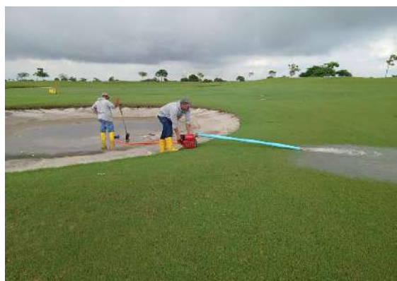
Actividad: Destape de drenaje en los búnkers del campo de práctica. Duración: 20 de febrero
