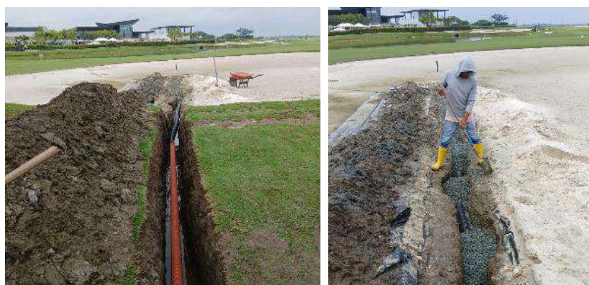
Actividad: Arreglo de filtro en hoyo 18
