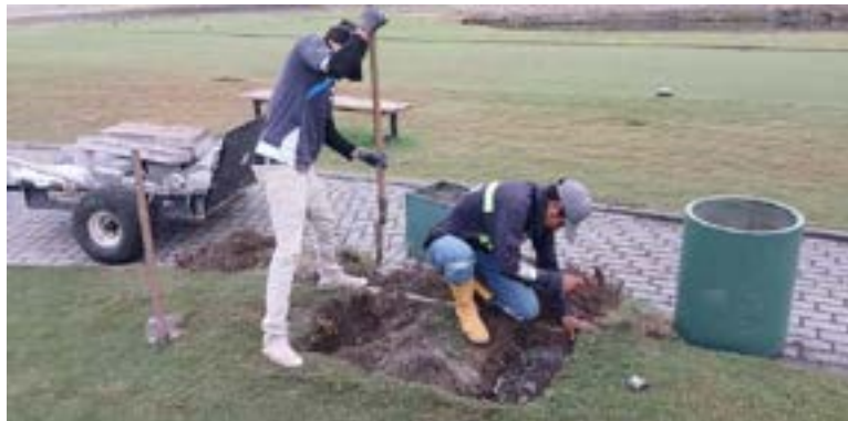
Actividad: Fabricación de bases con adoquines para tachos de basura y arena Duración: 18 y 19 de mayo
