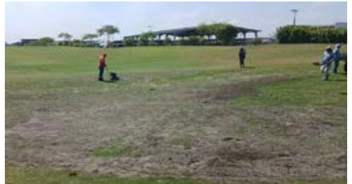
Actividad: Compactación y aplicación de topdressing para la nivelación del área de siembra en el hoyo 1 Duración: 29 de mayo
