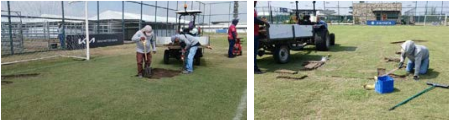
Actividad: Mantenimiento en cancha de futbol
