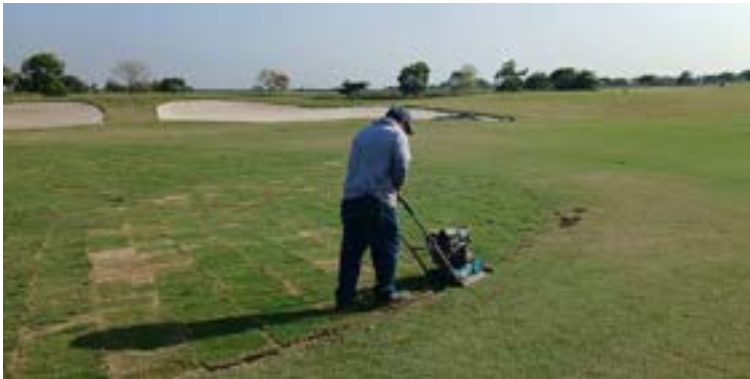
Actividad: Compactación y aplicación de topdressing para la nivelación del área de siembra en el hoyo 1 Duración: 29 de mayo
