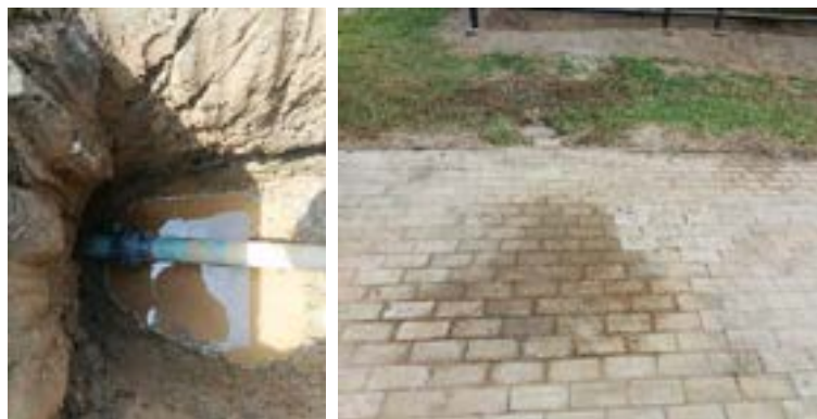
Actividad: Reparación hidráulica en el área de hípica Duración: 6 de mayo
