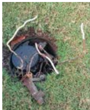
Actividad: Arreglo de cable sulfatado en el tee del hoyo 5 Duración: 11 de mayo
