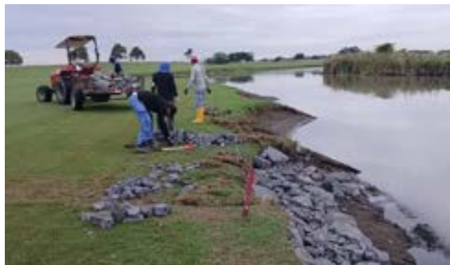
Actividad: Enrocado en el lago del hoyo 5 Duración: 4, 5, 6, 7 y 8 de mayo
