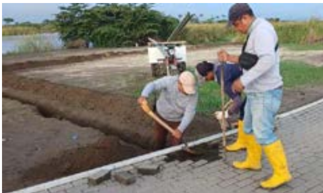
Actividad: Instalacion de tuberia de riego para vivero en hoyo 5 Duración: 7 y 8 de mayo
