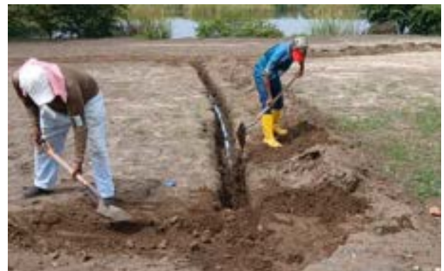
Actividad: Instalacion de tuberia de riego para vivero en hoyo 5 Duración: 7 y 8 de mayo
