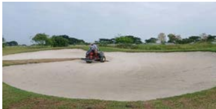
Actividad: Mantenimiento en bunkers Duración: 25, 26, 27, 28 y 29 de mayo
