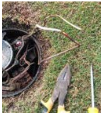
Actividad: Arreglo de cable sulfatado en hoyo 2, 3 y 7 Duración: 26, 27, 28 y 29 de mayo
