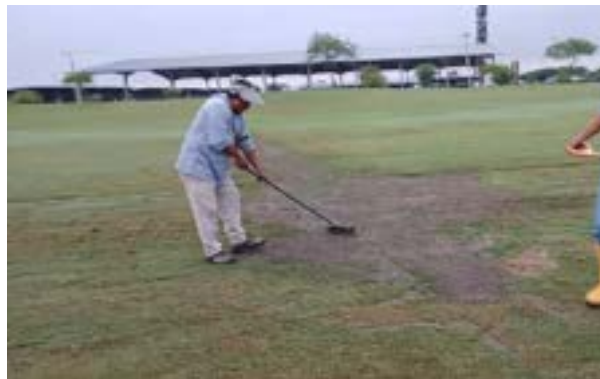
Actividad: Top dressing en zona donde se construyó tubería de drenaje en hoyo 1y7 Duración: 14 de mayo
