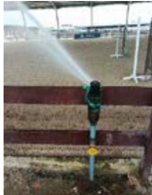
Actividad: Arreglo de tubería en el área de hípica Duración: 15 de mayo
