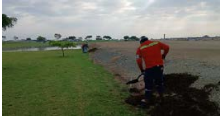
Actividad: Reubicación de aspersores para empalme en hoyo 14, 15, 17 y 18 Duración: 18, 19, 20, 21 y 22 de mayo
