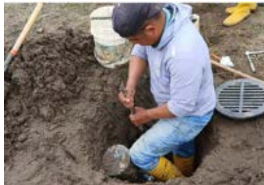
Actividad: Arreglo de tubería en el hoyo 18 Duración: 15 de mayo
