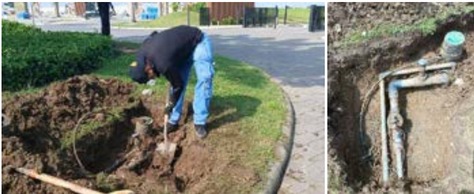
Actividad: Reparación hidráulico en jardín de garita principal Duración: 4 de mayo
