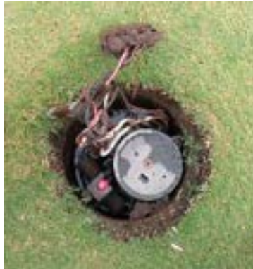
Actividad: Reemplazo de codificador en green del hoyo 8 Duración: 5 de mayo
