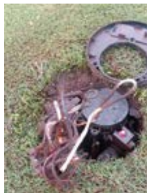
Actividad: Arreglo de cable sulfatado en hoyo 18 Duración: 11 de mayo
