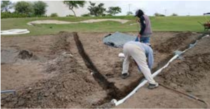
Actividad: Conformación de tubería y sembrado de grama en hoyo 1 Duración: 25, 27, 28 y 29 de mayo
