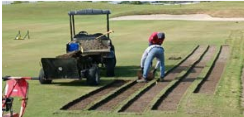
Actividad: Retiro de champa en campo de practica para mejora de zonas hundidas en cancha de futbol Duración: 26, 27, 28 y 29 de mayo
