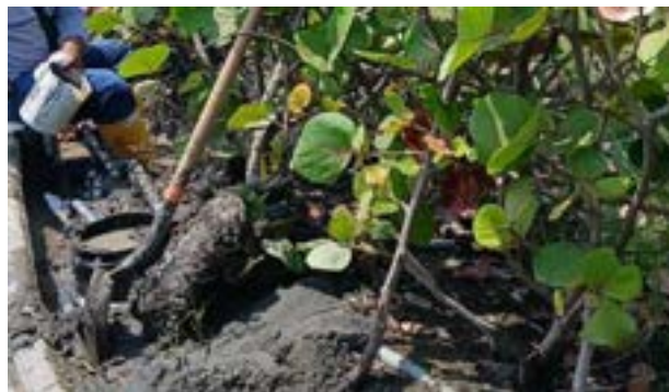
Actividad: Reparación hidráulica en área del muelle Duración: 07 de abril
