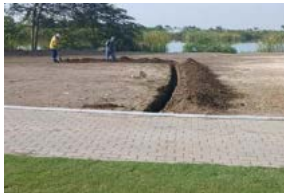
Actividad: Instalacion de riego Duración: 24 de abril
