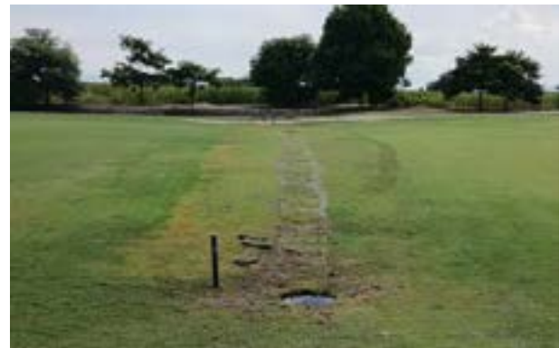
Actividad: Cambio de tubería de drenaje de 4 a 6 pulgadas en hoyo 7 Duración: 20, 21 y 22 de abril
