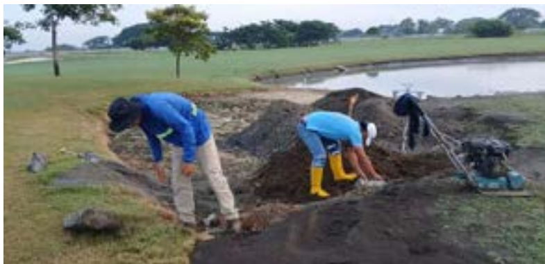
Actividad: Construcción de cross bunker en driving range Duración: 23 de abril
