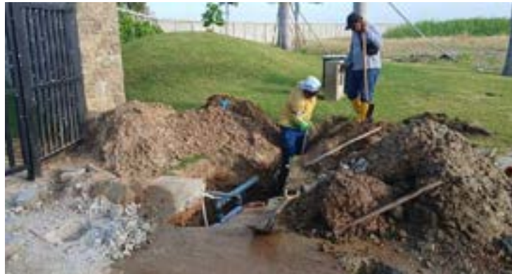
Actividad: Arreglo de tubería en garita principal Duración: 16 y 17 de abril
