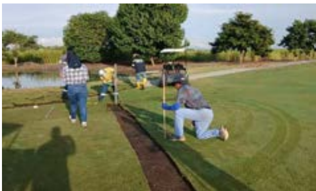
Actividad: Cambio de tubería de drenaje de 4 a 6 pulgadas en hoyo 7 Duración: 20, 21 y 22 de abril
