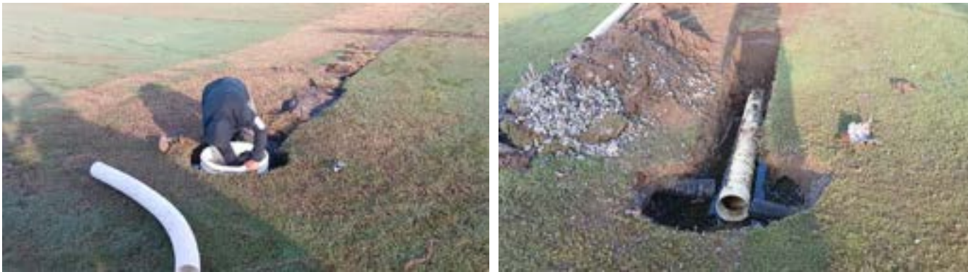
Actividad: Arreglo de sumideros y siembra de césped en hoyos 1 y 7 Duración: 20, 21 y 22 de abril
