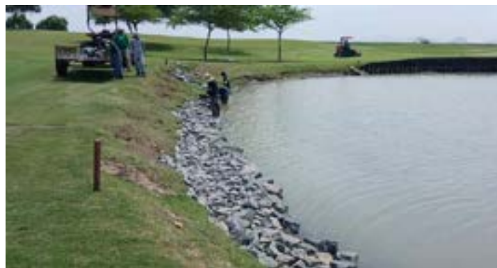
Actividad: Enrocado en el lago del hoyo 5 Duración: 27, 28 y 29 de abril
